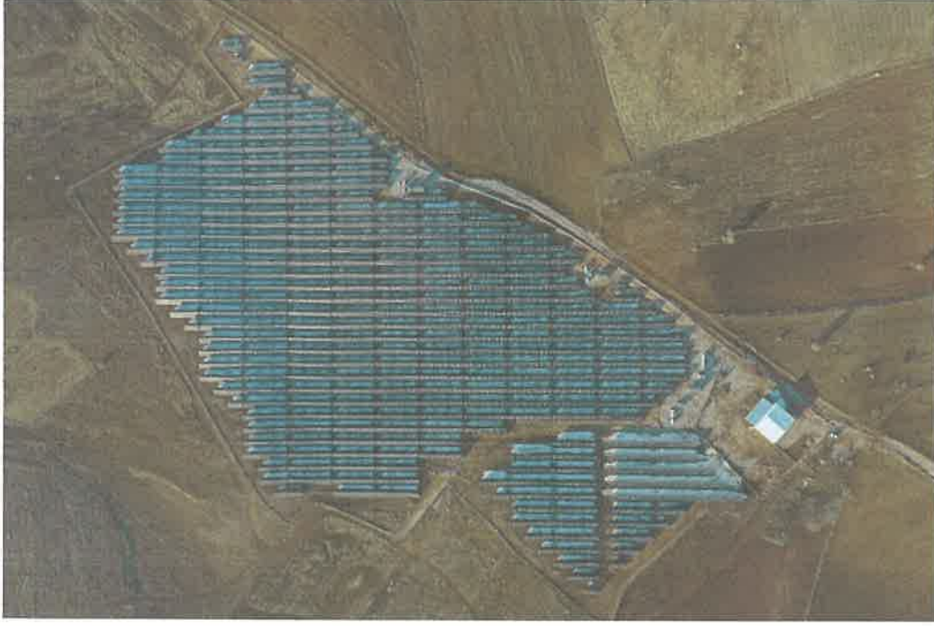
Görsel: Lisanssız Elektrik Üretim Tesis
